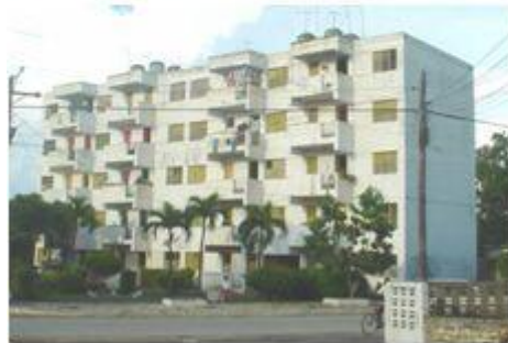
Foto 11: Obras de la temática de la vivienda con tecnología constructiva prefabricada. Edificios multifamiliares.
